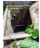
ตะแกรงดักขยะ บ่อพักสุดท้าย
